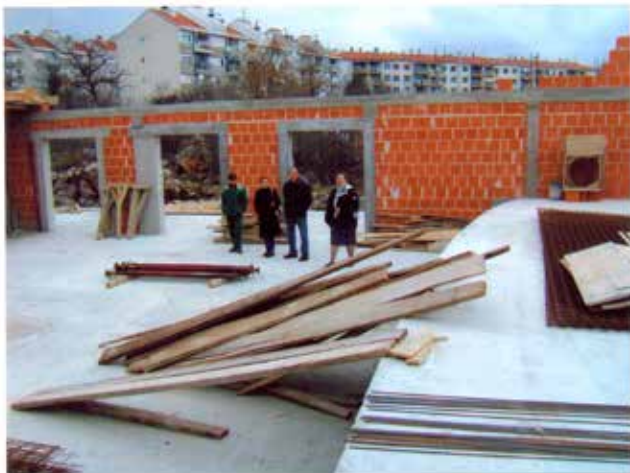
Na staveništi budoucího Českého domu T. G. Masaryka v Rijece. První zprava stojí Fanyňka Husáková
